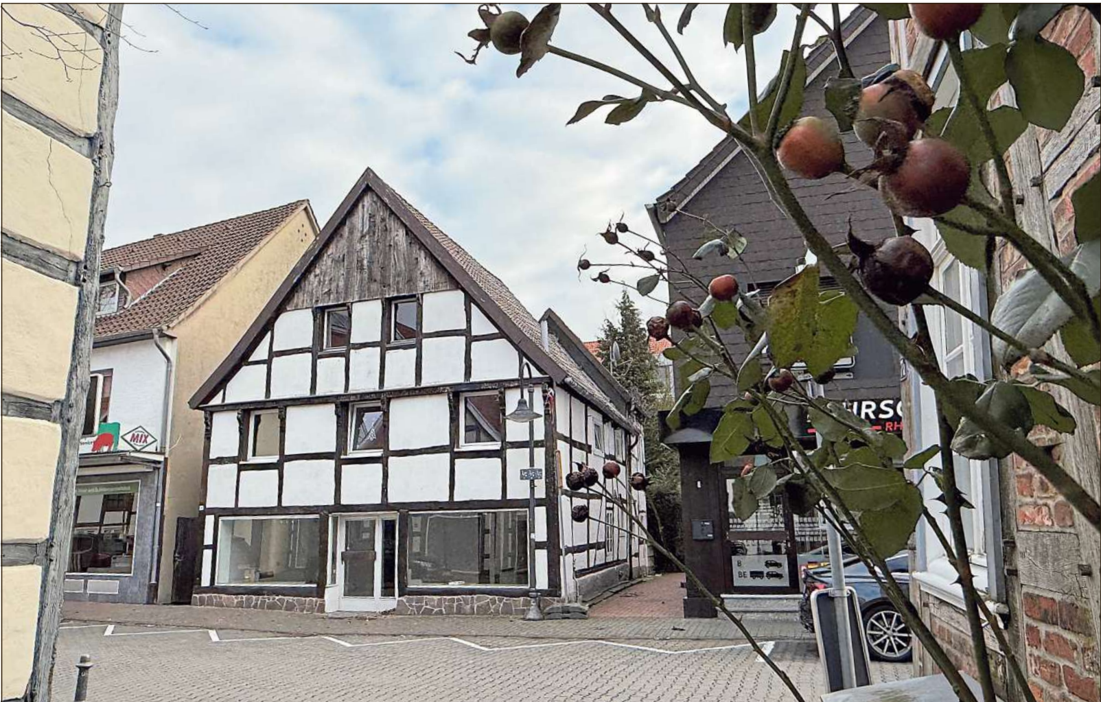
Die Zukunft des Hauses Berliner Straße 10 ist ungewiss. Doch auch die Vergangenheit der Immobilie ist nebulös: Der Heimatverein Rheda glaubt nicht, dass die vordere Fachwerkfassade original ist – unter anderem deshalb, weil sie nicht über ein Deelentor verfügt.
