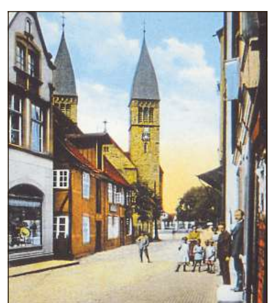
Weichen für den Weinberg-Neubau musste das Kaufhaus Augsburgsburger (rechts mit dem Baldachin).
