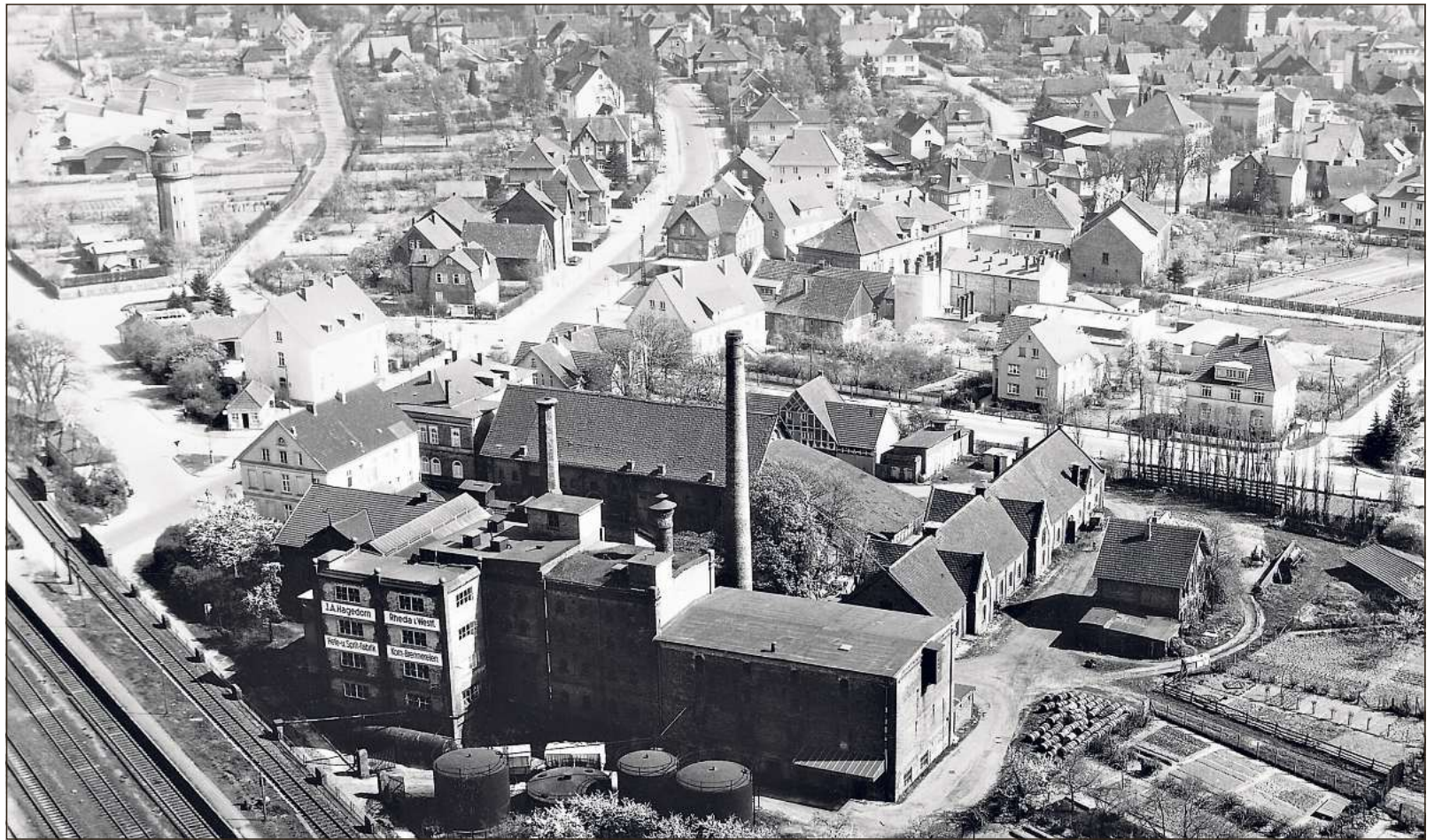
Die Geschäfte der früheren Brennerei Hagedorn liefen offenbar gut. Um 1900 gehörte der in Bahnhofsnahe angesiedelte Betrieb zu den größten Gewerbesteuerzahlern in Rheda. Die Abgabe trieb damals noch die preußische Verwaltung ein. Fotos: Archiv Sängler, Archiv Lewe
