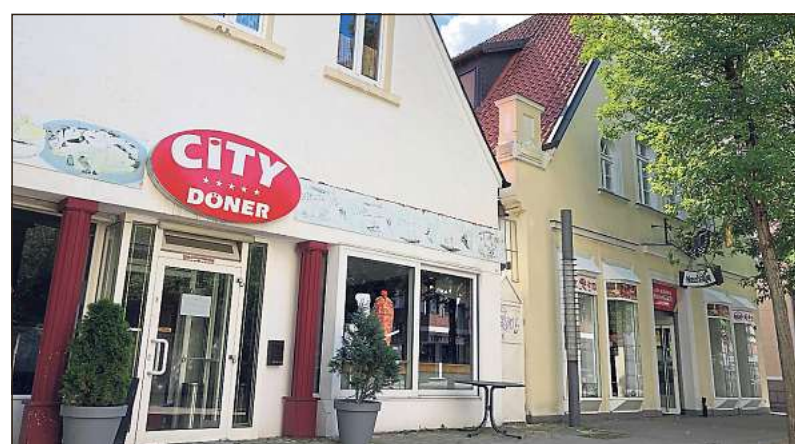
Einst war das als Fachwerkbau (l.) errichtete Geschäftshaus an der Berliner Straße 18 Wirkungsstätte des berühmten Arztes, Chirurgen, Apothekers und Medizinalrats Dr. Johann Christoph Ebermaier.
