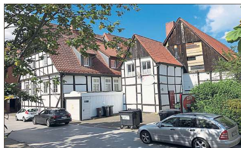
Von der Rückseite aus betrachtet, ist der Zustand der Immobilie an der Berliner Straße 18 in Rheda beklagenswert.
