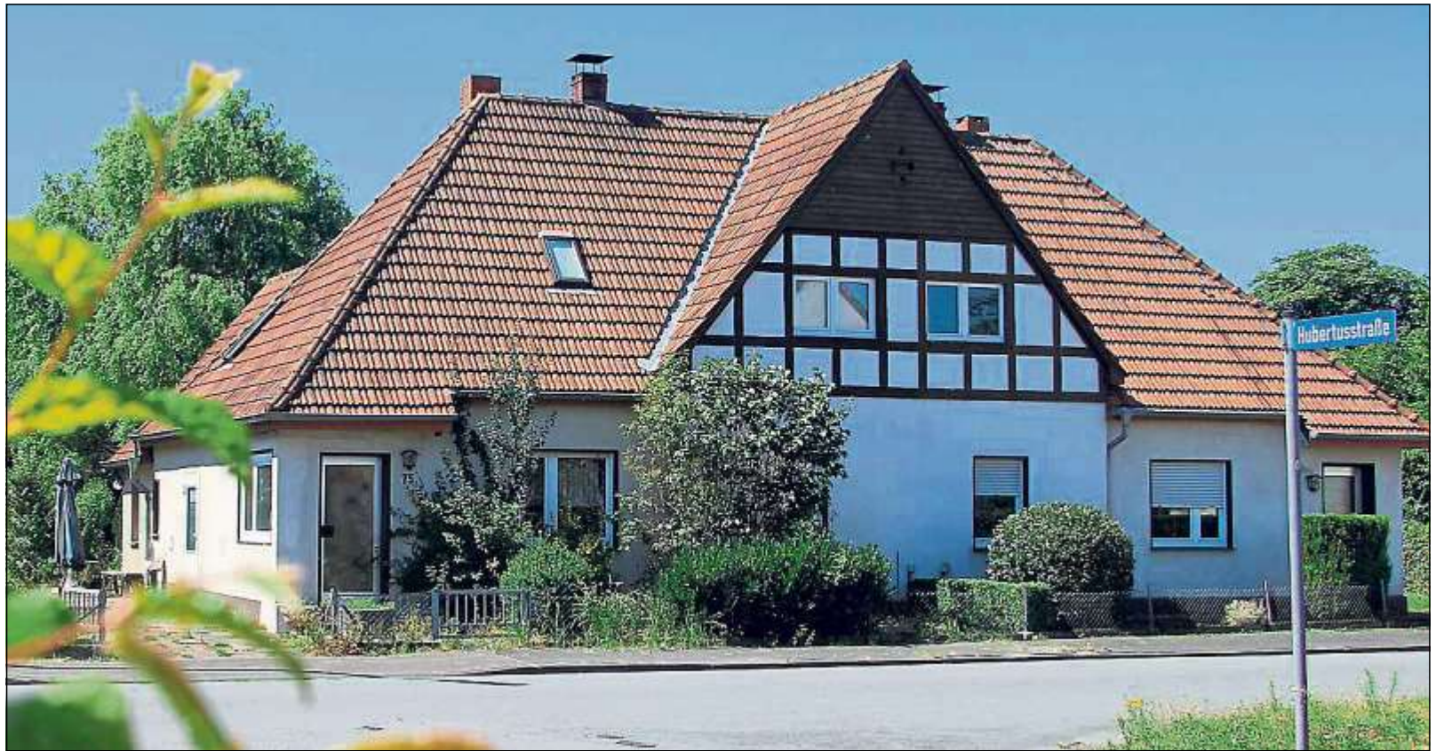
Schöner Schein: Die Fachwerkkoptik kann kaum darüber hinwegtäuschen, dass der Zahn der Zeit an den meisten der inzwischen mehr als 100 Jahre alten Häusern der Rhedaer Simonssiedlung genagt hat. Demnächst sollen fast alle abgerissen werden.
