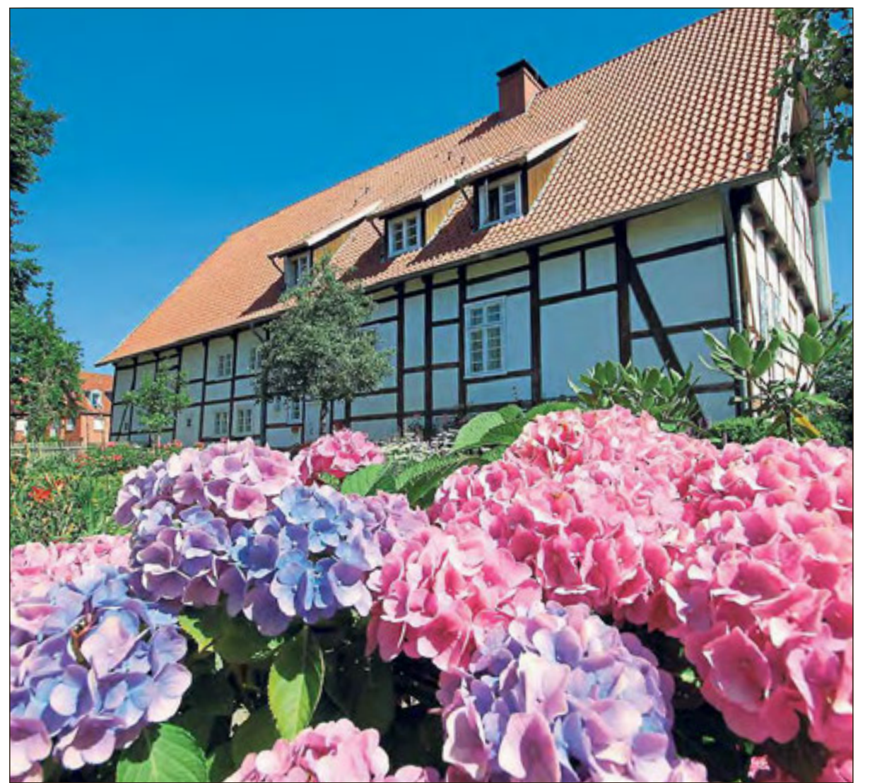
In voller Blüte: Auch 400 Jahre nach seiner Erbauung ist der Domhof eines der schönsten Fachwerkhäuser in der ehemaligen Fürstenstadt an der Ems. 1986 kaufte ihn die Kommune und restaurierte ihn mit Fördermitteln des Landes Nordrhein-Westfalen. Rechtzeitig zur Landesgartenschau im Jahr 1988 konnte das 27,5 Meter lange und 12,75 Meter breite Denkmal wiedereröffnet werden. Bilder: Sudbrock, privat
