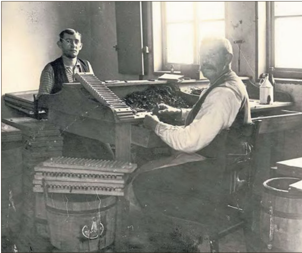
Akkordarbeit: Zur Blütezeit der Tabakwarenindustrie gab es in Rheda mehr als 170 Zigarrendreher. Per Hand wurden die sogenannten Stumpfen hergestellt. Diese Aufnahme stammt aus der Zigarrenfabrik Hark.
