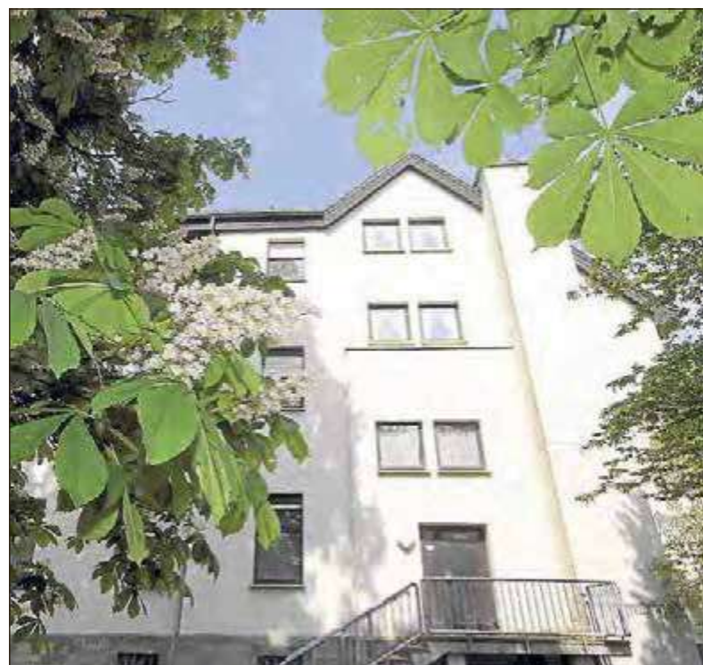
Das ehemalige Katholische Krankenhaus steht noch immer. Ab 1985 wurden die Räume als Seniorenheim genutzt. Bild: Werneke
