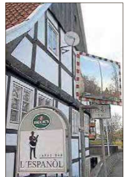
Die Holzbalken dieses Gasthauses am Doktorplatz stammen von der alten Münzpräge am Schloss.
