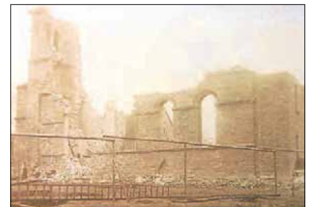
Ruine: Die Vorgängerkirche mit abgenommenem Dach und gesprengten Seitenwänden.
