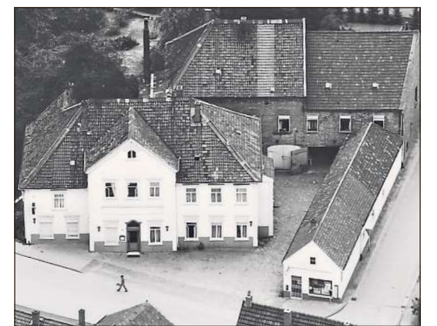
Das Hotel Allerbeck aus der Vogelperspektive. Die Aufnahme stammt aus dem Jahr 1972, also aus der Zeit kurz vor dem Abriss der Immobilie.
