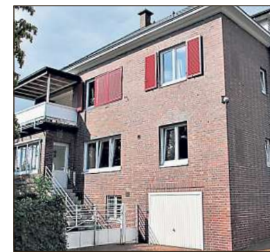
Die Garage ist ins Wohngebäude integriert. Bilder: Lewe
