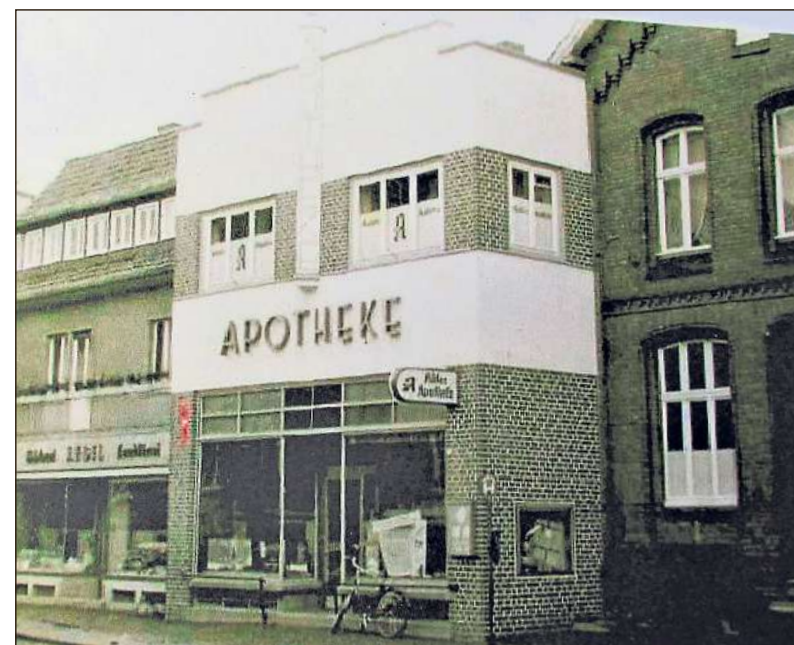
Die Apotheke, die am Reißbrett des Architekten Hermann Lenzen entstand, hebt sich deutlich von den Nachbarbauten ab. Bild: Sänger
