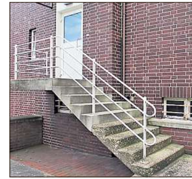
Am Hinterausgang befindet sich das originale Treppengeländer.
