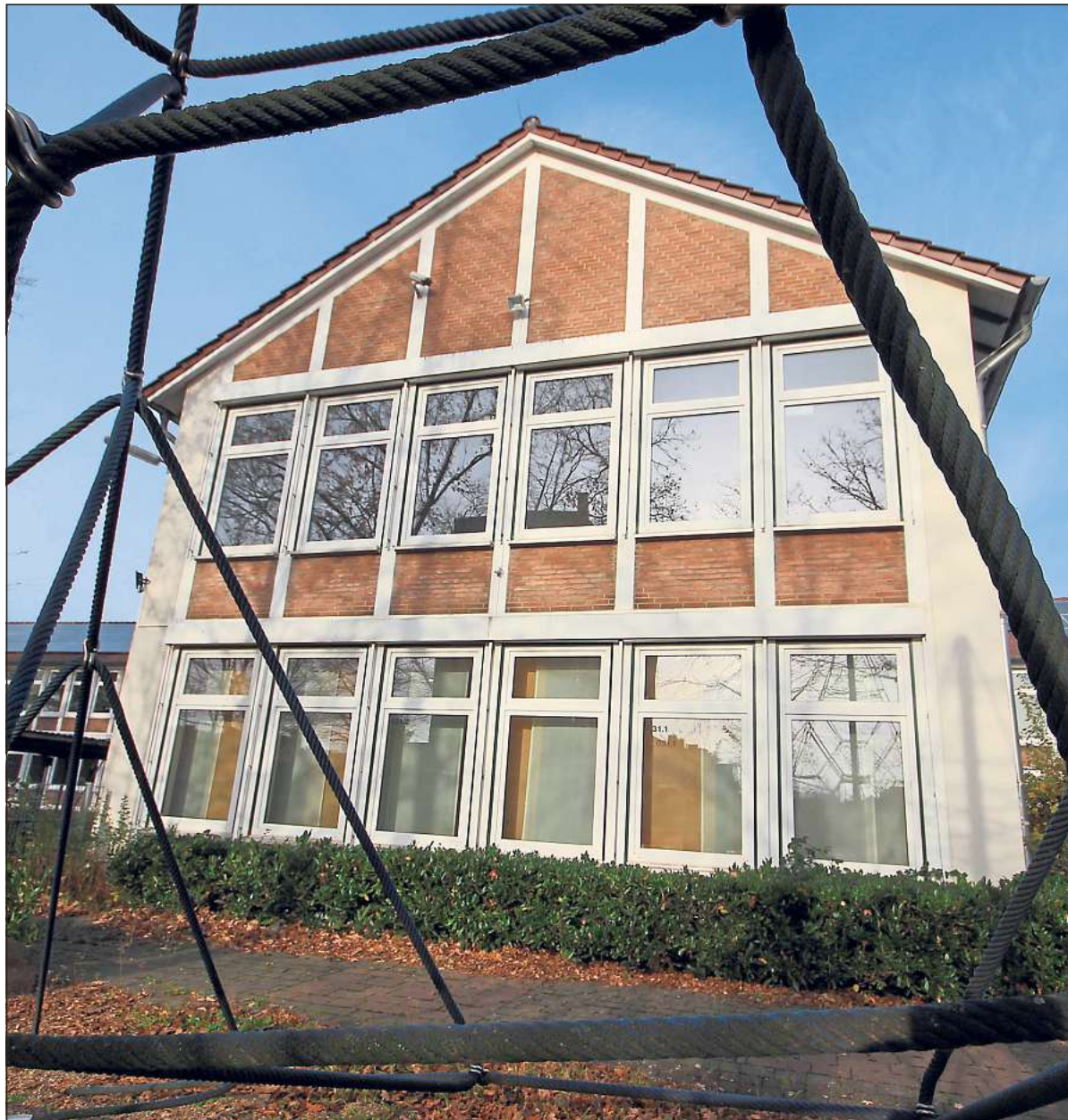
Der Verwaltungstrakt der ehemaligen Ernst-Barlach-Realschule an der Fontainestraße könnte zu einer Kindertageseinrichtung umgebaut werden. Diese Pläne sind jetzt Jugendhilfeausschuss thematisiert worden. In die frühere Realschule wird die Johannisschule einziehen, die dann Nachbarin des zweigruppigen Kindergartens wäre. Bild: Sudbrock
