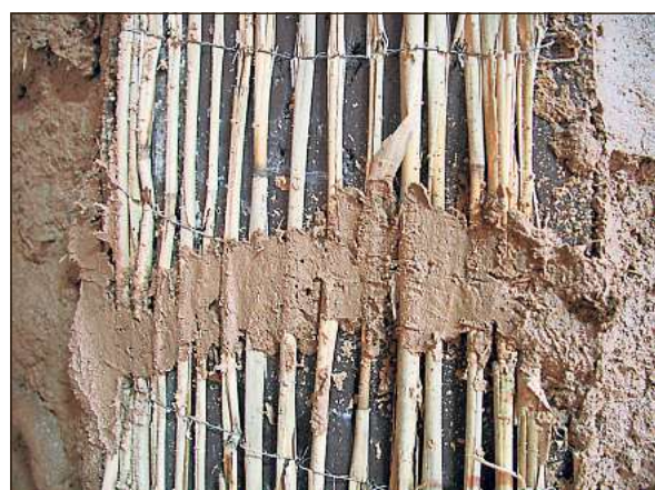
Ausschließlich alte Baustoffe werden bei der Sanierung des Roggenkamp-Hauses verwendet – wie hier der Lehmputz auf Schilfmatte.
