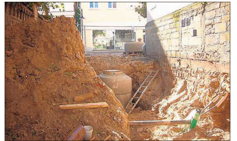
Fundgrube: Bei der Verlegung neuer Abwasserkanäle und Zuleitungen wurden an dieser Stelle die 500 Jahre alten Eichenpfosten entdeckt.
