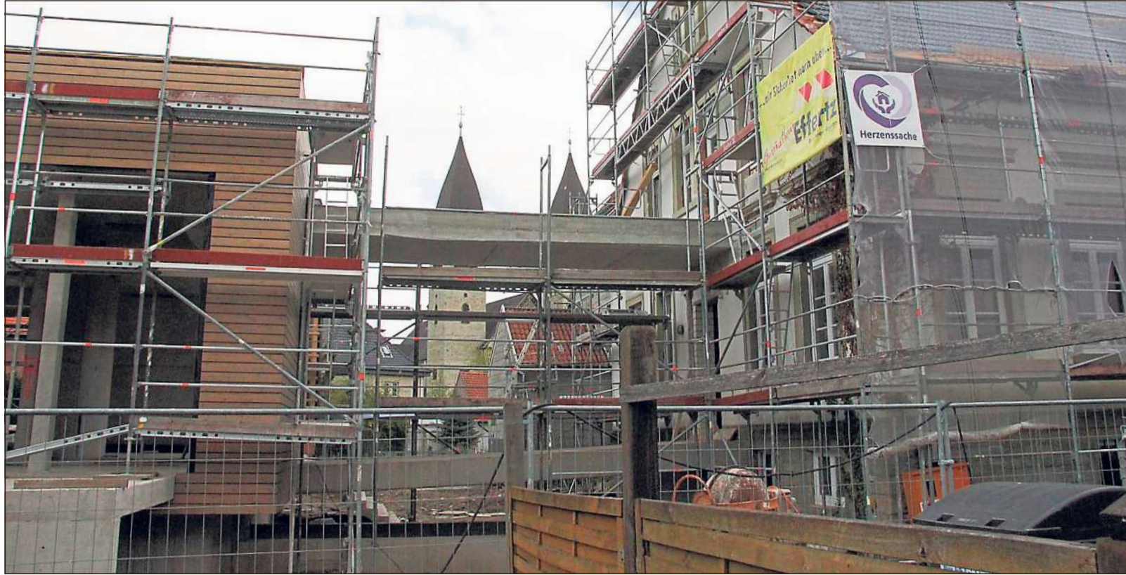
Glücksfall: Bei den Umbau- und Erweiterungsarbeiten am Schnitkerhaus wurden zwei mehrere Jahrhunderte alte Holzpfiler entdeckt. Diese geben Aufschluss über die Rhedaer Stadtentwicklung während des Mittelalters. Bilder: Archiv Jochen Sänger, Wassum, privat
